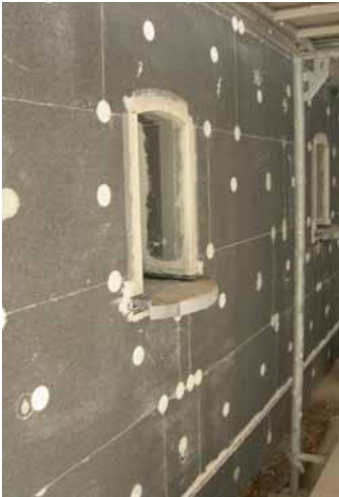
Afb. 15: Extra verankering van de isolatie.
