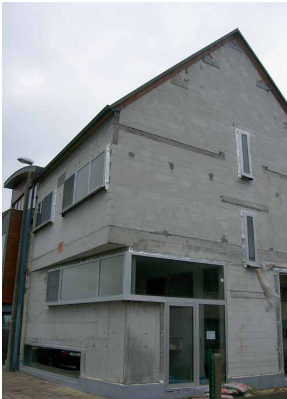
Afb. 1: Gebouw klaar voor het aanbrengen van het ETICS.
