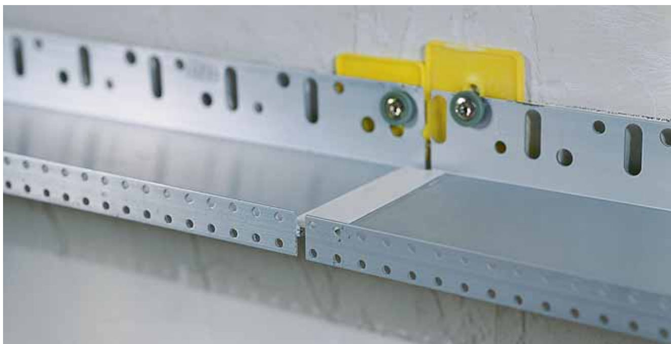
Afb. 11: Plaatsen van het sokkelprofiel met behulp van afstandhouders en verbindingstukken.
