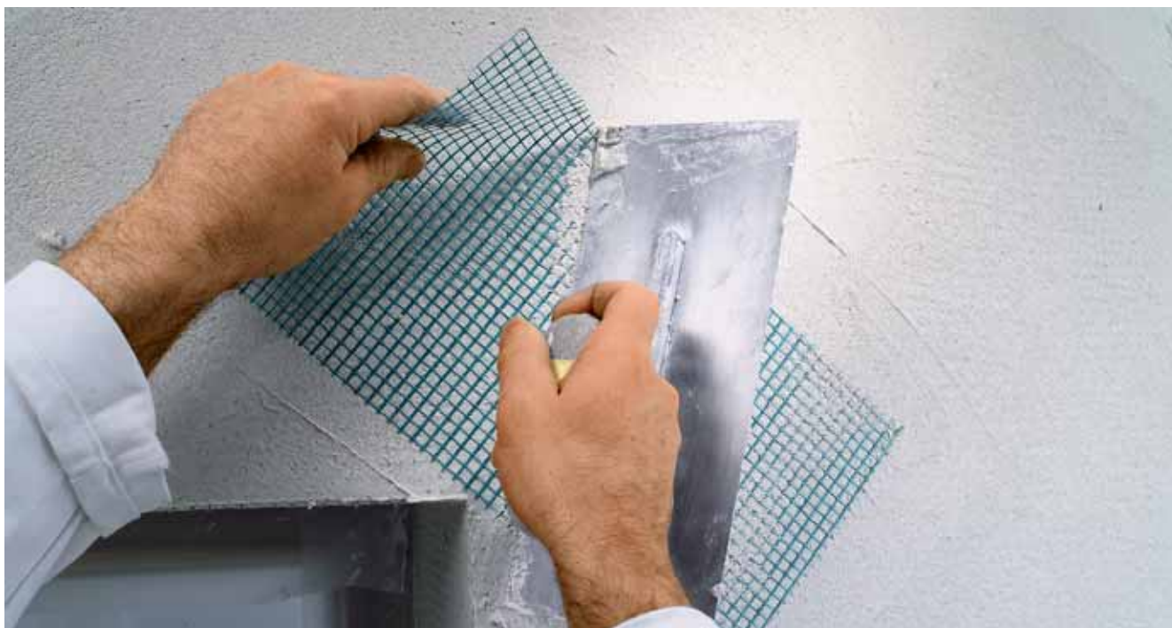
Afb. 19: Aanbrengen van diagonaalstroken.
