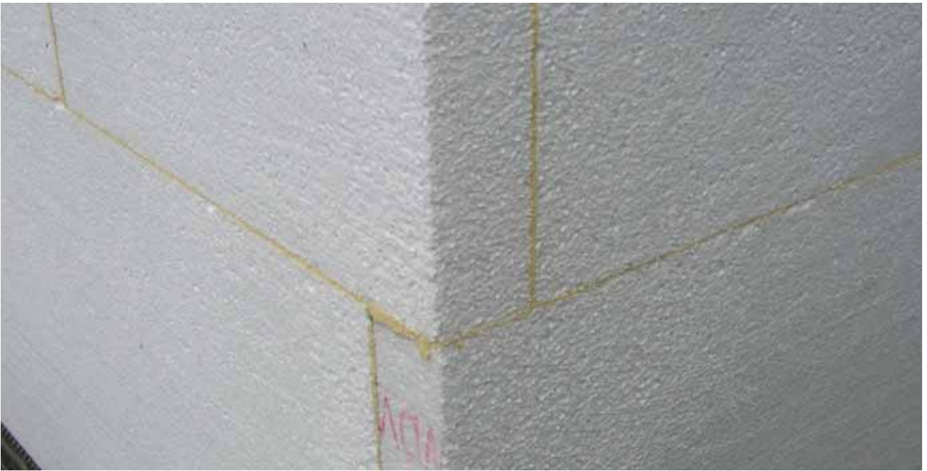
Afb. 14: Open naden opgevuld met PU-schuim.
