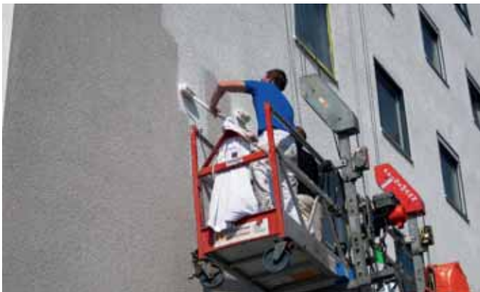
Afb. 29: Aanbrengen van verflaag.
