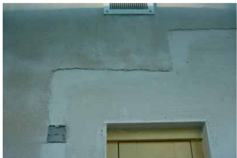
Afb. 30: Plaatselijke herstelling van wapeningslaag
