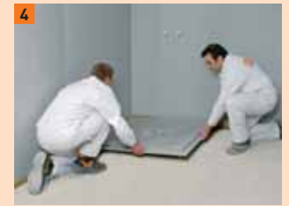
4 Variant 1b: ter hoogte van de bovenkant van de afvoerbehuizing wordt het volledige oppervlak van de ruimte met de gebonden vloeregalisatie afgereid en na droging het inlooptdouche-/vloerafvoerelement geplaatst
