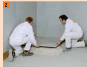
2 Variant 1a: ter hoogte van de bovenkant van de gestelde afvoerbehuizing wordt alleen in het gebied van het inlooptdouche-/vloerafvoerelement de gebonden vloeregalisatie afgereid en na droging het inlooptdouche-/vloerafvoerelement geplaatst
