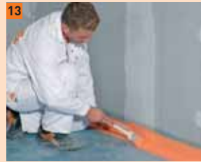
13 FERMACELL Vloeibare folie op de afdichtband aanbrengen
