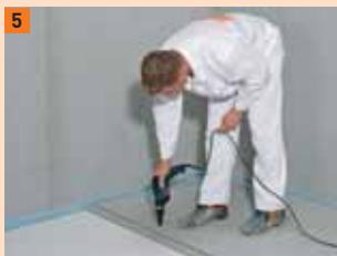
5 Bevestigingsmiddel: Powerpanel schroeven...
