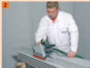
2 Voor de eerste rij vloerelementen tegen de wand de liplas afzagen
