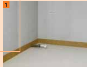
1 Nadat de positie van het inlooptdouche-/vloerafvoerelement is gemarkeerd, wordt de afvoerbehuizing geplaatst
