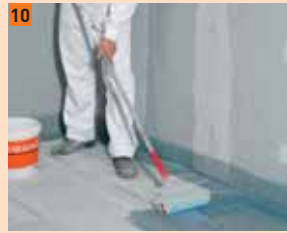
10 ...vervolgens met een roller op de vloer
