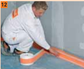
12 FERMACELL Afdichtband in de vochtige vloeibare folie drukken
