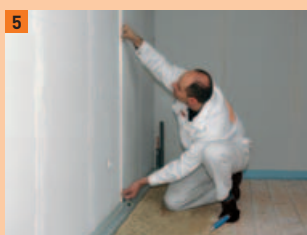
5 De storthoogte controleren
