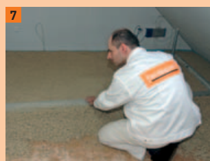
7 Wanneer het gebonden egalisatiemiddel tussen de dammen gestort is, kan het afreien beginnen
