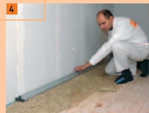
4 De eerste dam uitrichten
