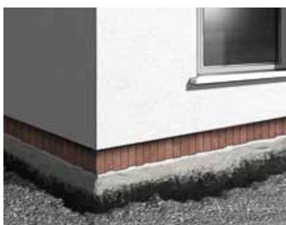
Metselwerk (sokkel niet geïsoleerd)
