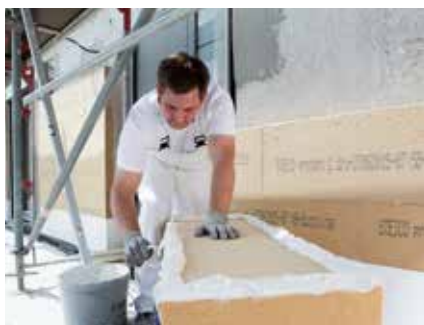
Isolatiemateriaal lijmen
