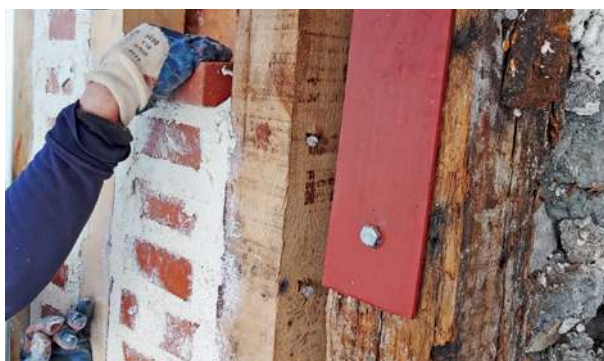
Opnieuw opvullen tussen houten secties.
