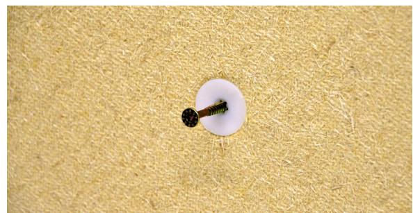
met 4-5mm schroef de last bevestigen
