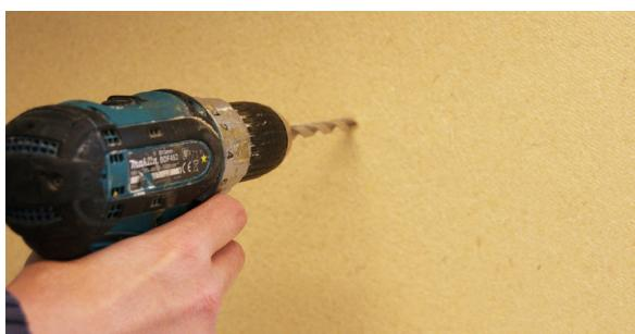
niet-gestucte plaat met 8mm houtboor voorboren
