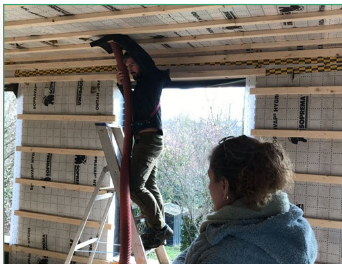
EXIE Fibres wordt ingeblazen
