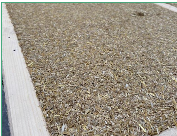
EXIE Fibres in een prefab houtskelet
