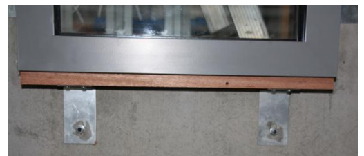
Figuur 4: houten onderregel onder raam
