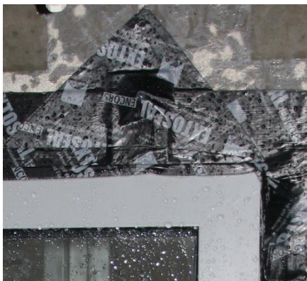
Figuur 12: Patch voor afdichting raamankers
