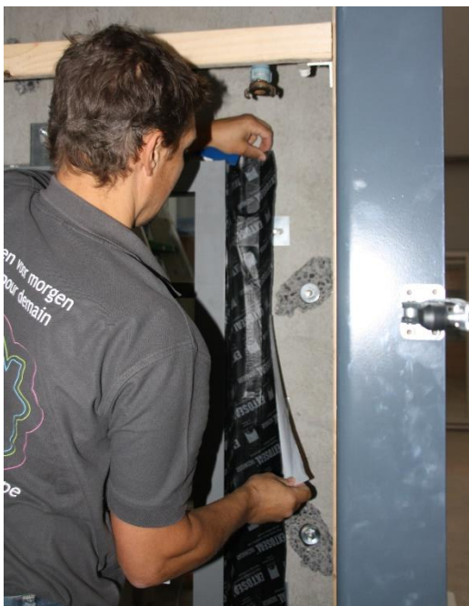
Figuur 8: plaatsing van EXTONSEAL ENCORS
