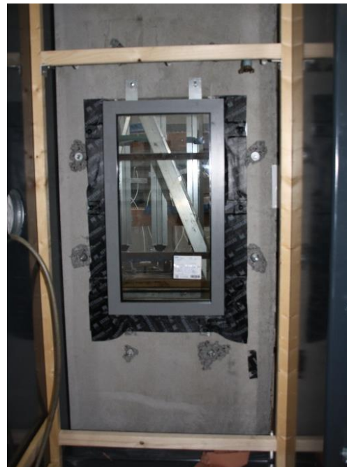
Figuur 9: onder- en zijstroken geplaatst
