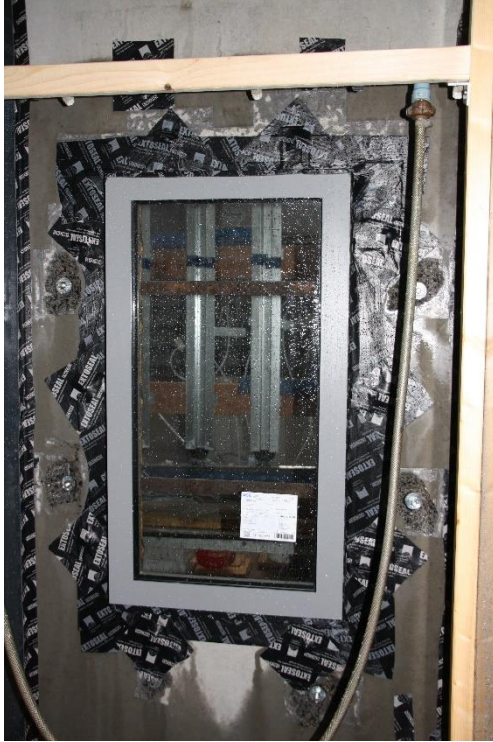
Figuur 10: alle stroken + patchen geplaatst
