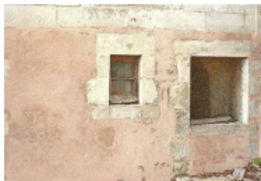
Niet behandeld met Sanimur
