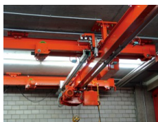
Fixation de pont roulant sur parpaing
