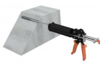
Gat voor de helft tot twee derde vullen vanaf het bodemgat naar buiten door bij het pompen telkens één maatstreep op de spuitmond achteruit te gaan
