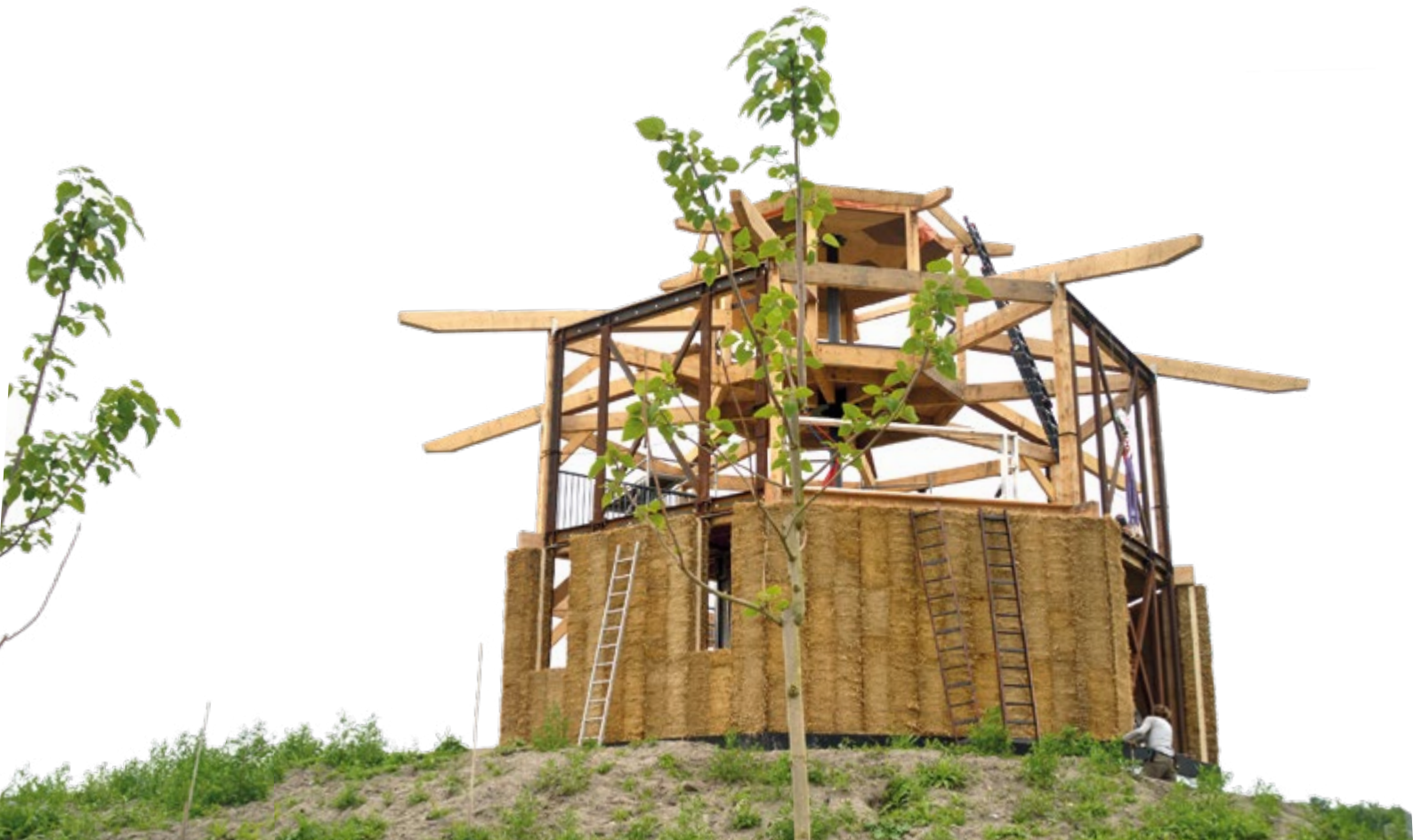
Achtkantige meer dan 10 m hoge woning met werkplaats in Almere gerealiseerd met prefab gevel- en dakelementen van Straw Blocks Systems.
